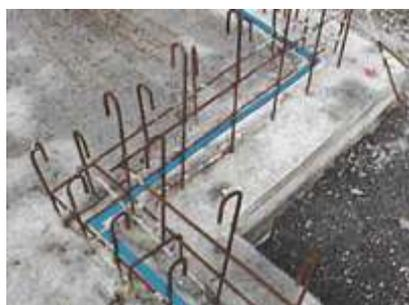
4) Рекомендуемая температура нанесения клея  $+10^{\circ}\text{C} \div +40^{\circ}\text{C}$  и относительная влажность воздуха не более 80%. После приклеивания выдержать в течение 20 минут.
