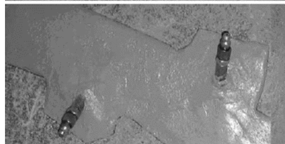
Рисунок 1. Пакеры, установленные вокруг трещины и герметизированные эпоксидным клеем MasterBrace или MasterFlow
