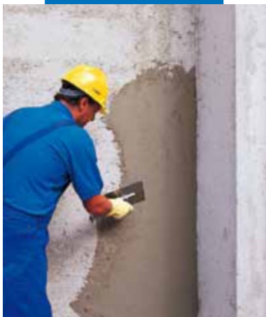
Нанесение шпателем
