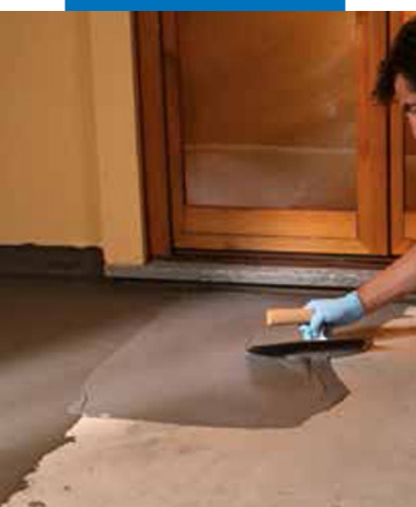
Нанесение гидроизоляции на террасе с помощью шпателя
