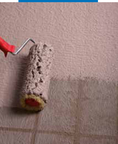
Нанесение гидроизоляции с помощью валика
