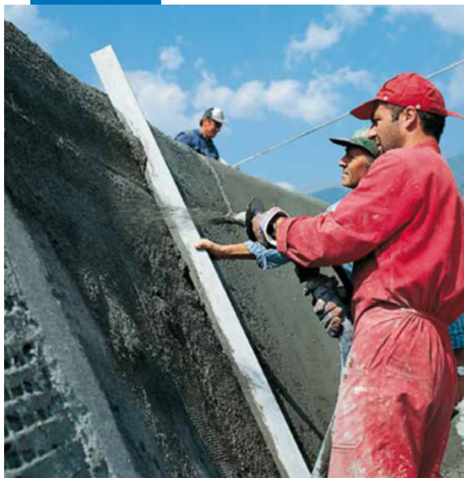
Механизированное нанесение Мапегроут Т40
