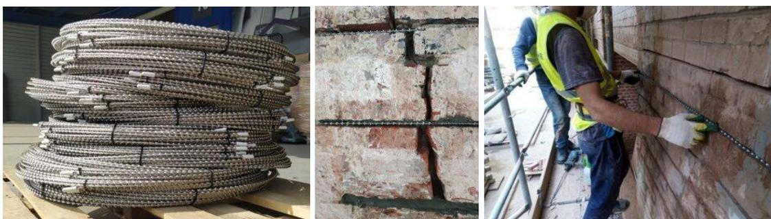
Поверхность раскатанных «крыльев» становится чрезвычайно твердой, при этом сердечник остаётся относительно эластичным. Последующая скрутка придает «крыльям» предварительное напряжение, а сердечник, благодаря отличной структуре, данному воздействию не подвергается, благодаря чему прочность при растяжении увеличивается более чем в два раза.
