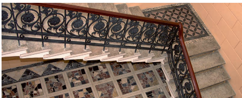
Плитки «брекчия» и «терраццо». Санкт-Петербург, Дом ветеранов сцены им. М. Г. Савиной
