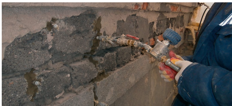
Инъектирование кладки. Санкт-Петербург, Московский пр., д. 60
