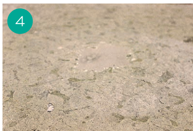
Реставрация ступеней из известняка материалом «Рунит Мульти-ремонт»
