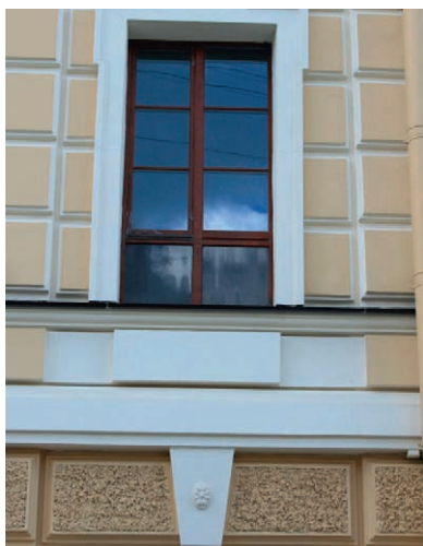
Архитектурные детали из стеклофибробетона. Санкт-Петербург, Литейный пр., д. 26
