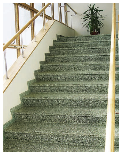
Реставрация мозаично-бетонной лестницы. Выборг, библиотека им. А. Аалто
