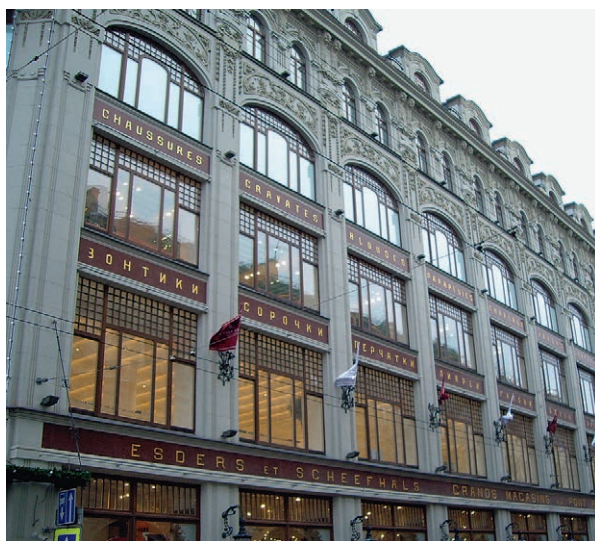
Набережная реки Мойки, д. 73. В условиях низких температур использовали штукатурку «Рунит Оригинальная крупная (М)» и шпаклевку «Рунит Шпаклевка Универсальная (М)»
