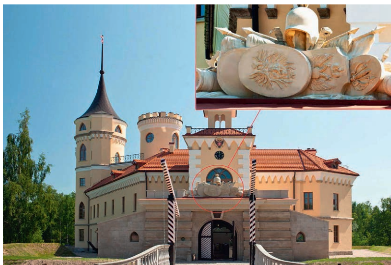
Архитектурные детали из стеклофибробетона. Крепость БИП, г. Павловск, Санкт-Петербург
