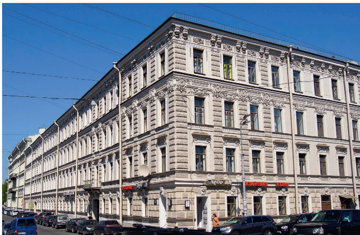
Ул. Декабристов, д. 27. В условиях низких температур использовали штукатурки «Рунит Оригинальная крупная (М)», «Рунит Оригинальная накрывочная (финишная) (М)», «Рунит Для карнизов и тяг накрывочная (М)», и шпаклевку «Рунит Шпаклевка Универсальная (М)»
