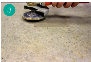
Реставрация ступеней из известняка материалом «Рунит Мульти-ремонт»
