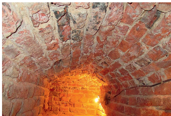
Исходный вид кирпичной кладки. Санкт-Петербург, Ростральные колонны
