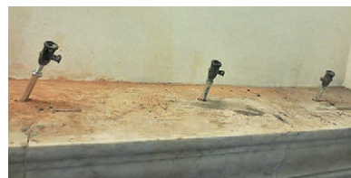
Установленные пакера, гидроизоляция наружных конструкций ст. метро «Автово»
