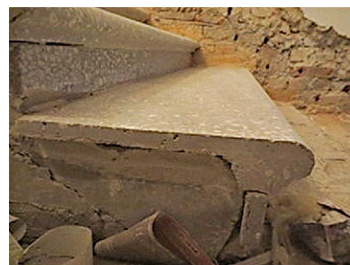
Реставрация мозаично-бетонной лестницы. Санкт-Петербург, аэропорт Пулково-2
