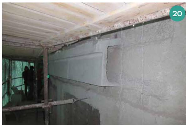
15–16. Здание Гаража Крюммеля до реставрации. Санкт-Петербург, ул. Большая Посадская, 17. Монтаж венчающего карнизного элемента из СФБ. 18. Схема крепления венчающего карниза. 19. Монтаж промежуточного карниза из стеклофибробетона. 20. Монтаж карниза из стеклофибробетона.
