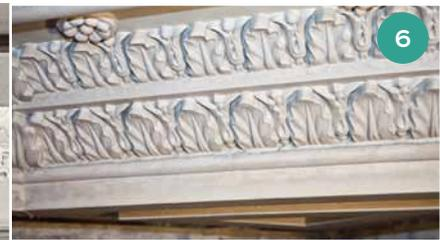
1. Подготовка потолка станции Автово. 2. Изготовление кессона. 3. Выемка кессона из формы. 4. Монтаж кессона из СФБ. 5-6. Подвесной потолок из СФБ.
