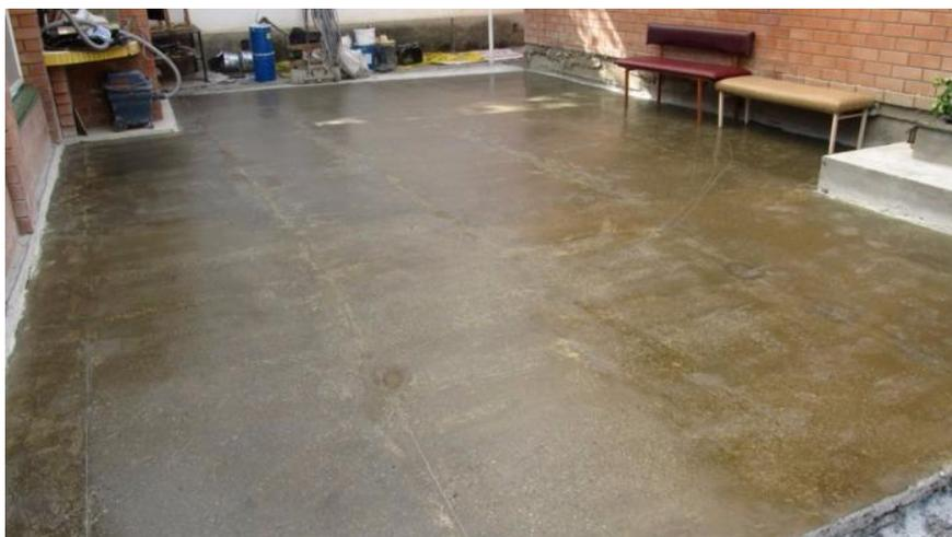
Покрытие наносится при помощи безвоздушного распыления, кисти или валика. Рекомендуемая температура нанесения 0°C...плюс 30°C (возможно от минус 10°C).
