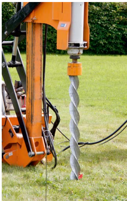
Einrammen der Gewindepfähle Pile-driving
