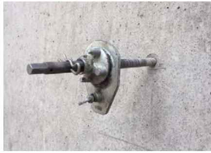
Anwendungsbeispiel: Abdichten des Bohrloches nach Einbringen eines Ankers | Example of use: Sealing of the borehole after insertion of an anchor
