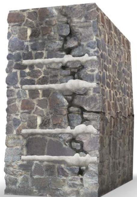
Anbindung abgelöster Mauerwerkschalen Connection of separated wythes
