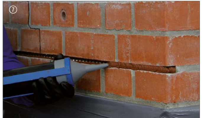
7 Zweite Lage DESOI Spiralanker einbringen | Insert second layer of DESOI spiral anchor
