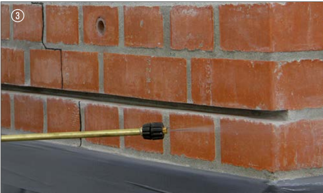
3 Fuge vornässen | Wet the joint/slot
