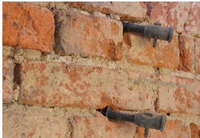
Einsatz von Lamellenschlagpacker mit Verschlussstück | Use of lamella drive-in packer with shut-off piece
